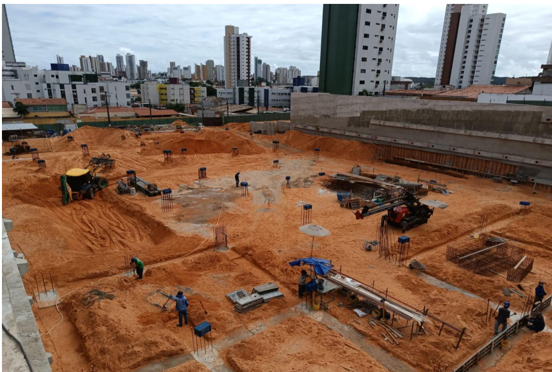
Figura 1. Visão geral da obra.
