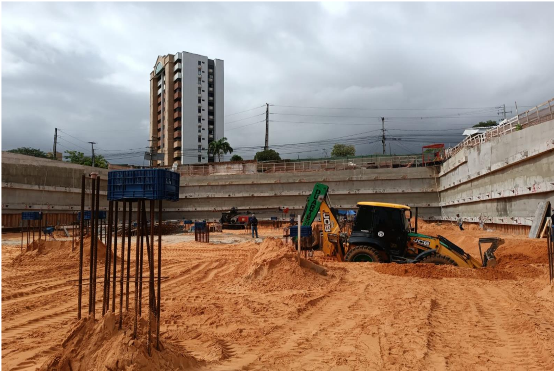
Figura 3. Retirada da berma na quarta linha de tirante e escavação para execução dos blocos do fosso do elevador.
