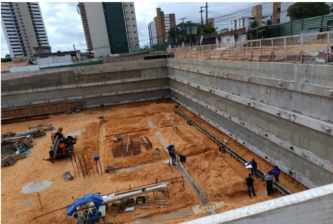
Figura 5. Furo para instalação do tirante e concretagem da viga tirante
