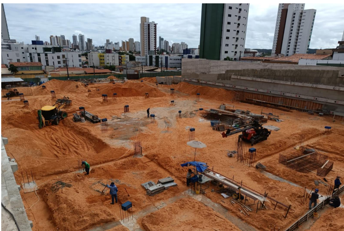
Figura 7. Blocos de coroamento e estacas de fundação.
